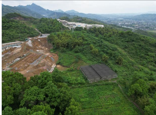
沿线药材园地
