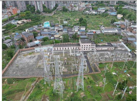
电缆沿线旱地
