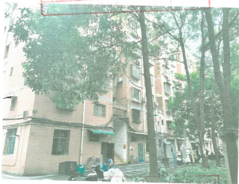
图 1.1 拟加装电梯建筑物现状
