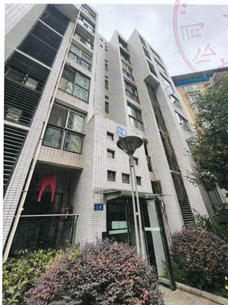
附图一：南川区九都尚品 5 栋现场照片
