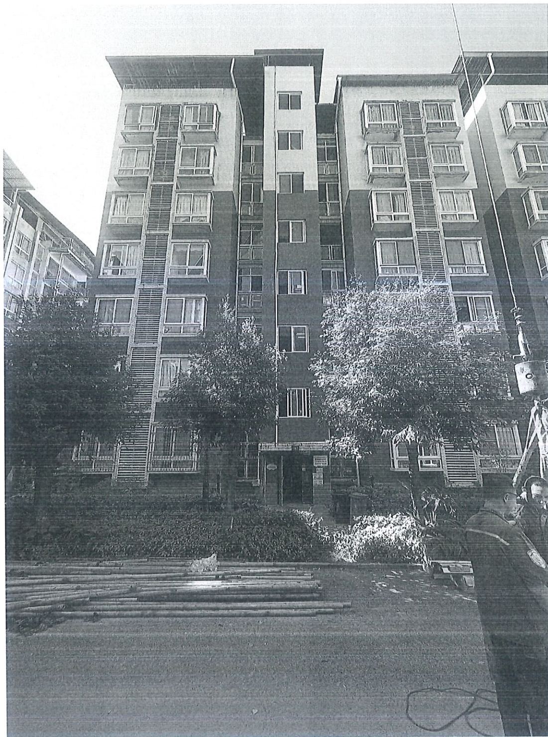
图 1-1 南川区金佛社区金易城市花园 5 栋 1 单元外观图
