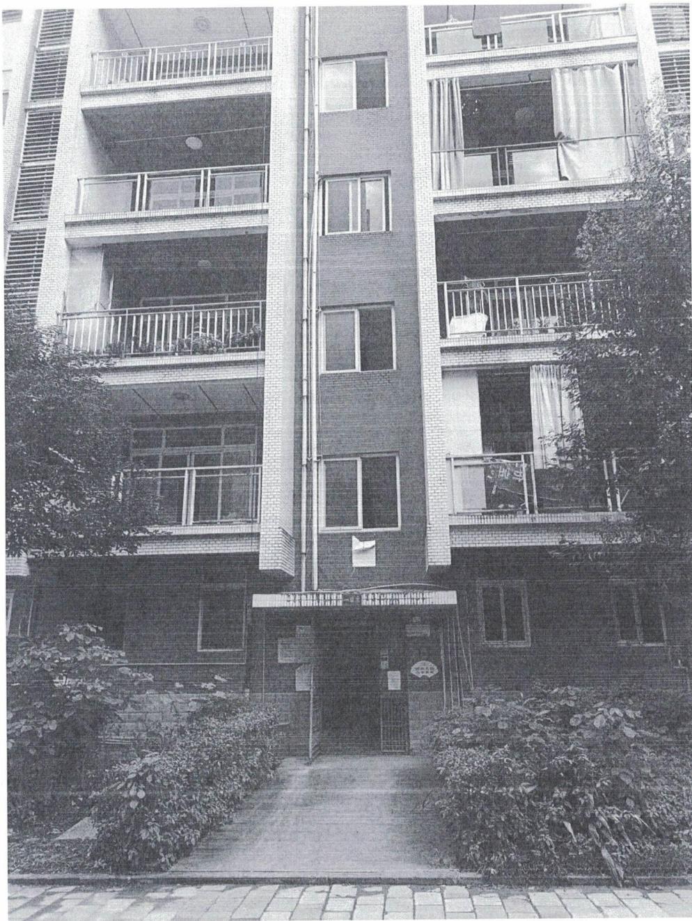
图 1-1 南川区金佛社区金易城市花园 2 栋 1 单元外观图
