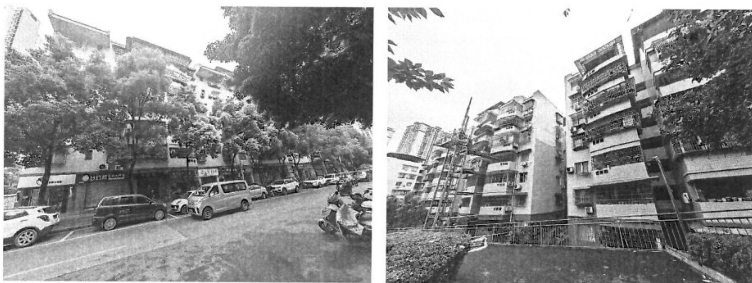
图 1-1 房屋外观现状
